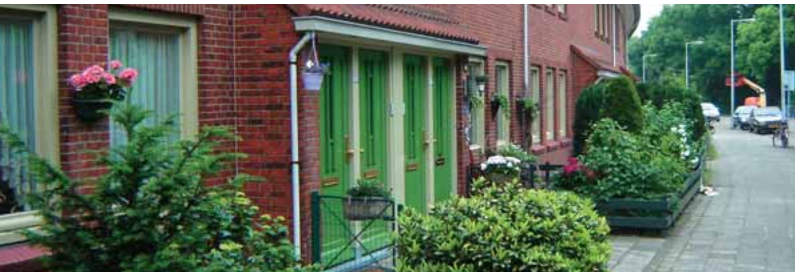
Na de renovatie
